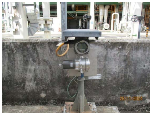
รูปที่ 49 Gas Detector
