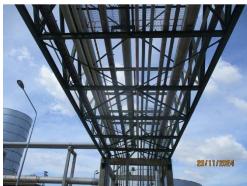
รูปที่ 5 ระบบรวบรวมสารอินทรีย์ระเหยเพื่อนำไปเผาในหอเผาของโรงงานอีเทนแครกเกอร์
