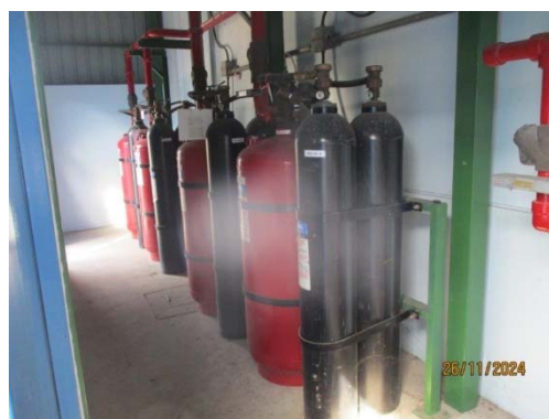
รูปที่ 53 Fixed Gas Fire Extinguisher System (FM-200)
