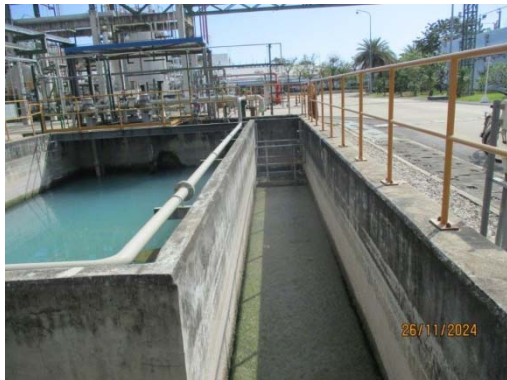
รูปที่ 9 Oil Separator
