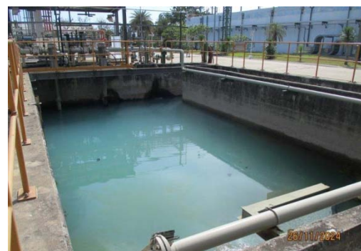
รูปที่ 12 บ่อพักน้ำทิ้งขนาด 260 ลูกบาศก์เมตร
