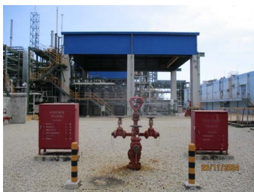
รูปที่ 46 Water Hydrant
