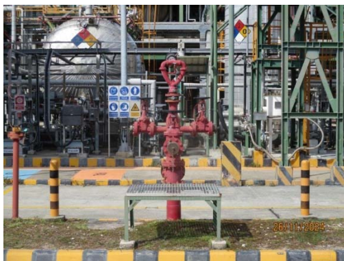
รูปที่ 44 Water Hydrants with Water / Foam Monitors
