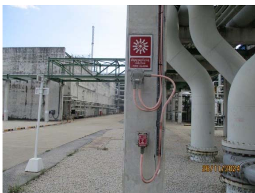
รูปที่ 50 Manual Pull Station
