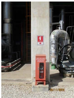
รูปที่ 48 Portable Fire Extinguishers
