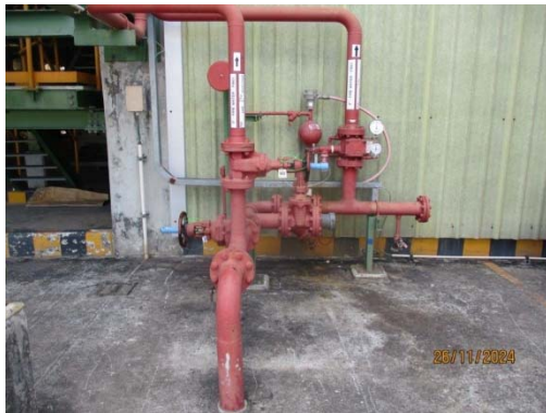
รูปที่ 42 Wet Alarm System
