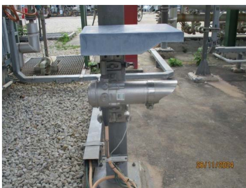
รูปที่ 51 Flame Detector
