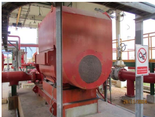
รูปที่ 58 Electric Fire Pump
