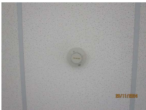
รูปที่ 52 Smoke/ Heat Detector
