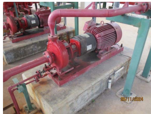
รูปที่ 59 Electric Jockey Pump
